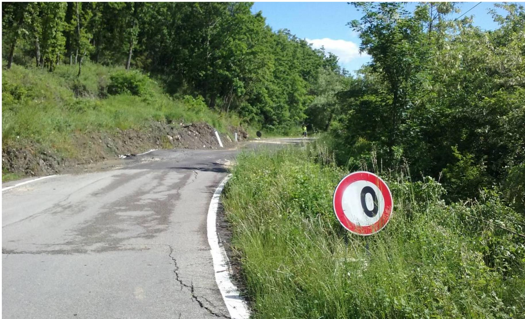
Foto 1 e 2: panoramica della viabilità comunale nel tratto interferente con il dissesto in massa. La carreggiata mostra lesioni e rigonfiamenti del piano viabile. L'accumulo franoso ha inoltre interrotto la cunetta di regimazione delle acque stradali ubicata sul lato monte della viabilità.
