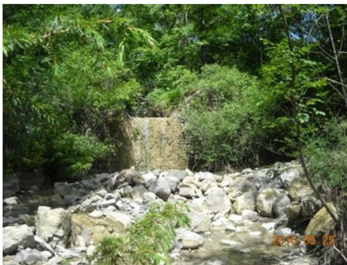
Foto 16: briglia n° 4 vista da valle con particolare dell'accumulo di materiale
