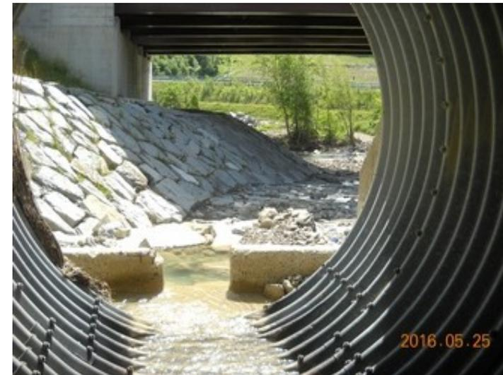
Foto 29: particolare dell'imbocco dell'attraversamento sul fosso della Badia Nuova
