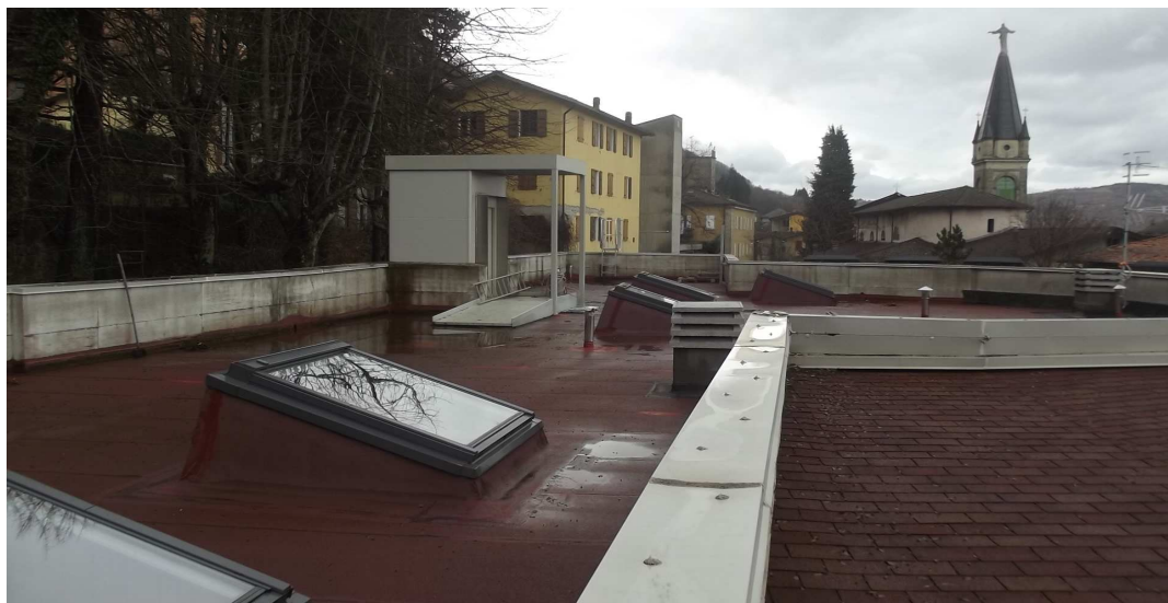
Terrazza di copertura, area attività motorie terapeutiche
