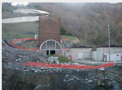
Roncobilaccio: centrale di ventilazione.
